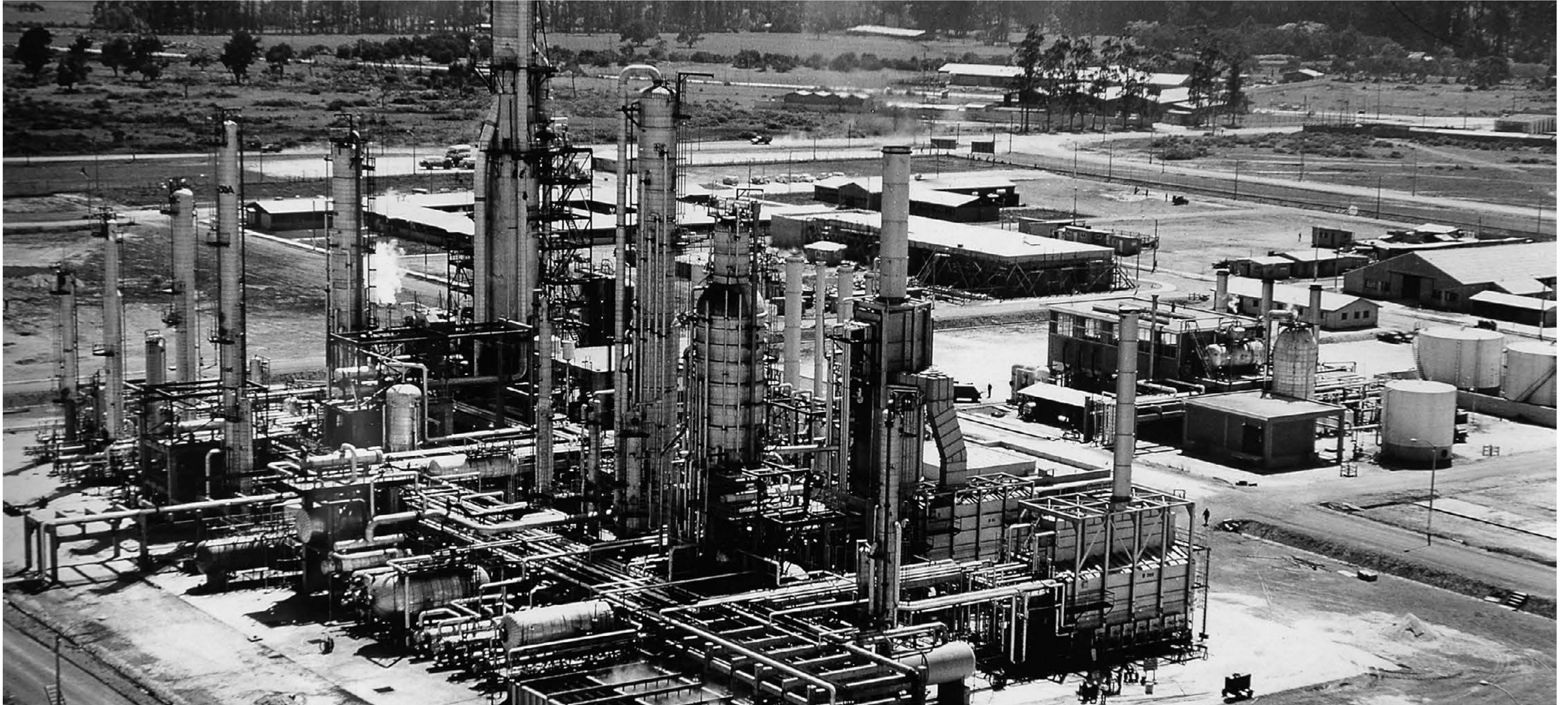
En las refinerías de Enap nacen los combustibles que mueven a Chile.
