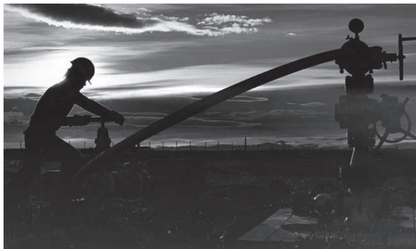
Operador de producción realizando maniobras en un pozo de hidrocarburos, llamado comúnmente "árbol de pascua".
