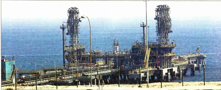
La semana pasada Enap comenzó un proceso abierto de búsqueda de socios para desarrollar proyectos por 1.250 MW. En Mejillones opera un terminal de GNL (en la foto) que abastece a centrales térmicas y a la minería.
